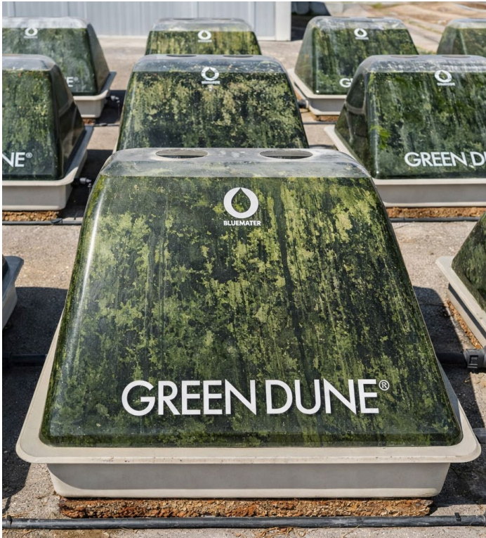
Εικόνα 3. Φωτοβιοαντιδραστήρες GREEN DUNE® εγκατεστημένοι στο Κέντρο Επεξεργασίας Λυμάτων Θριασίου Πεδίου, στην Ελλάδα
